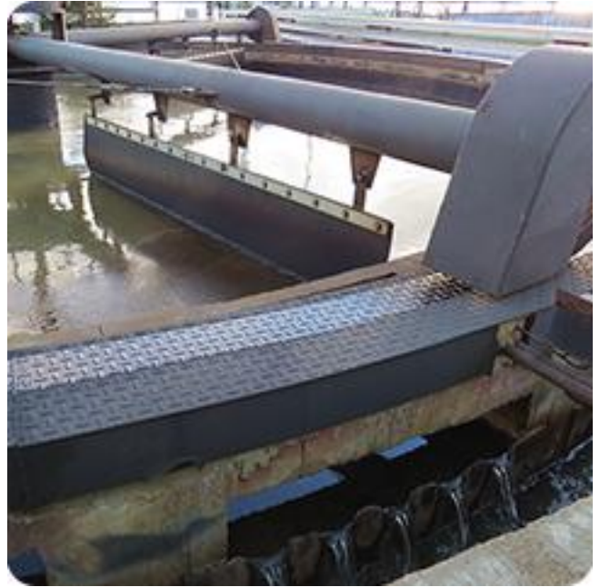
Jätevedet käsitellään ensin mekaanisesti kuorimalla. Sen jälkeen puhdistus jatkuu kuvassa näkyvällä kemiallisella puhdistuksella ja lopulta vesi johdetaan biologiseen puhdistukseen.
